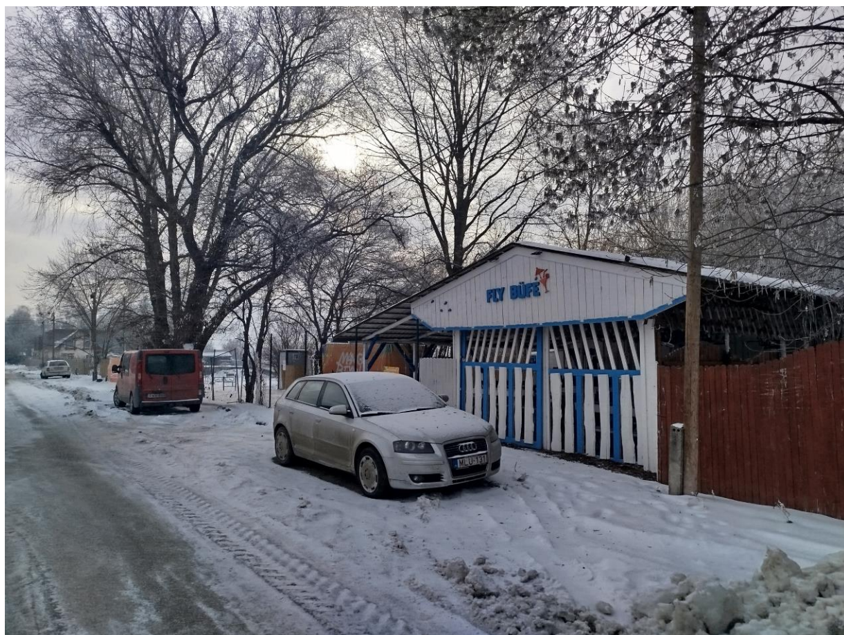
A strandhoz tartozó pavilon jellegű épület
